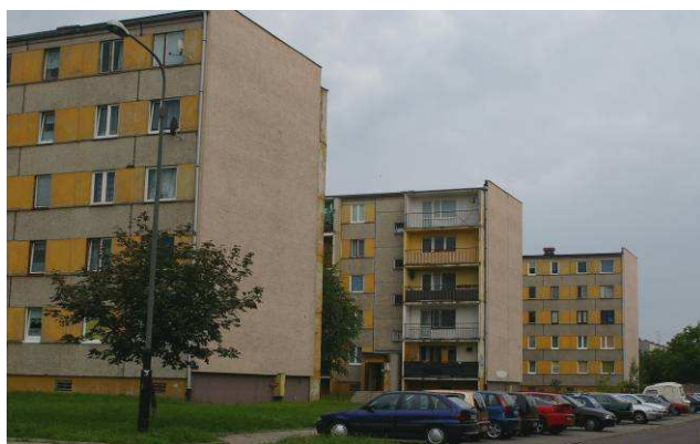
Zdj. Zabudowa wielorodzinnna, osiedlowa
