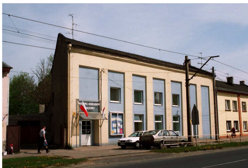
Fotografia 8 - Murowany dom, ul. Łódzka 28 – obecnie Miejski Ośrodek Kultury (źródło: karta gminnej ewidencji zabytków).
