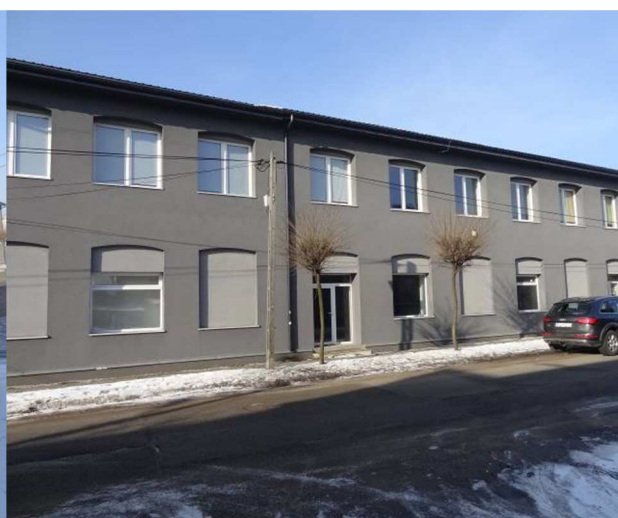
Fotografia 4 - Widok na budynek usługowy przy ul. Łabentowicza.
