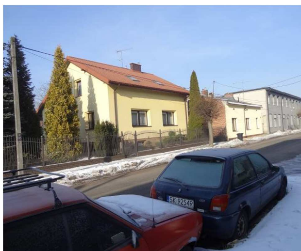
Fotografia 3 - Widok na budynek mieszkalny przy ul. Łabentowicza.
